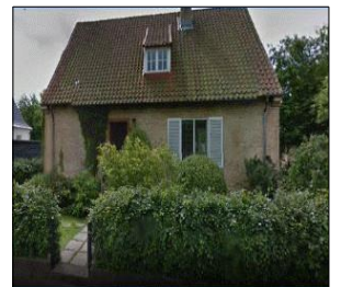
Enghavevej 20, Hjørring Fra Google (2008)
